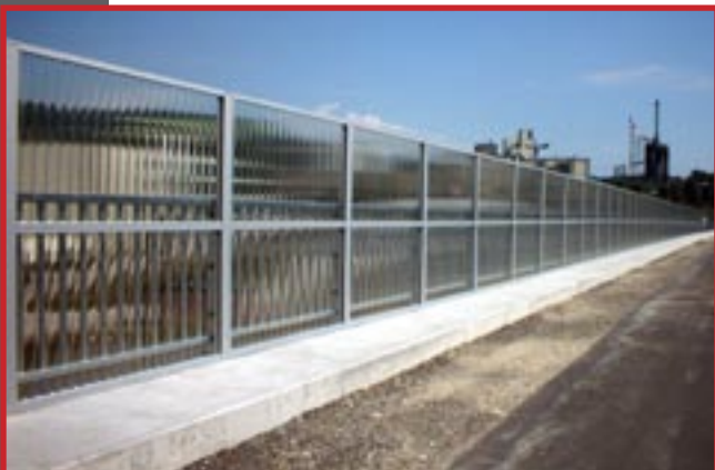
Übersteigenschutz mit WELLEX® Spritzschutz
