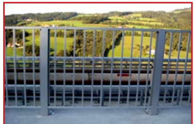
Übersteigenschutz mit Aluminiumsprossen
