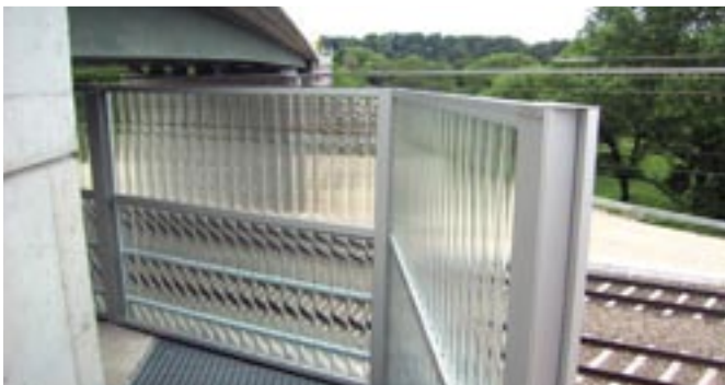
Fahrleitungsschutz mit winkeligem Übergang
